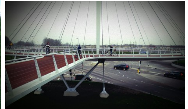
Passerelle giratoire pour franchissement d'une intersection complexe Pays-Bas (crédit photo : Inddigo)
