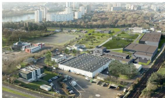
Usine de l'eau de la Roche à Nantes
