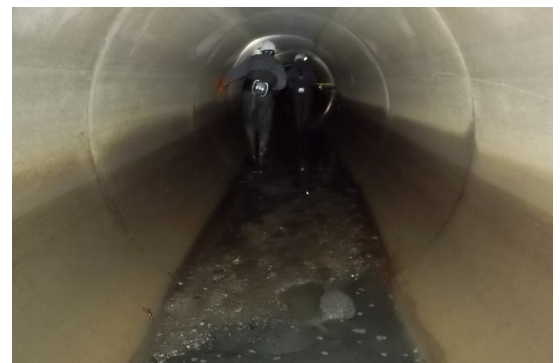
Exemple d'une opération menée à l'intérieur du réseau d'assainissement visitable
