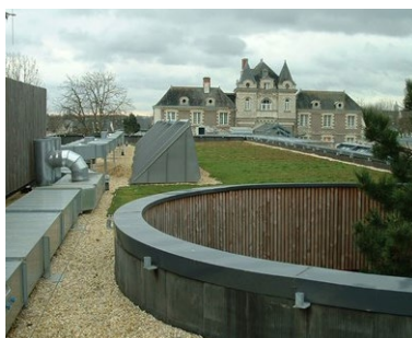
Toiture de la Médiathèque Saint-Luce-sur-Loire
