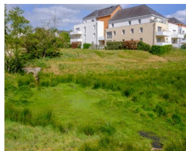
Carquefou : Bassin à sec
