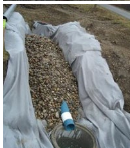
Mise en œuvre d'une chaussée à structure réservoir
