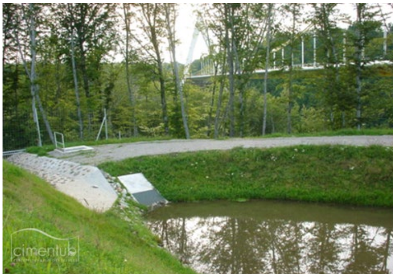
Ouvrage de régulation et surverse accessibles
