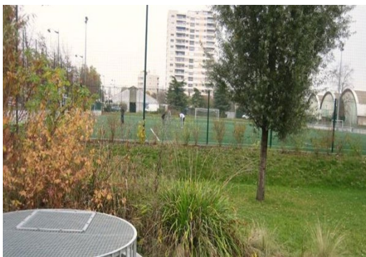
Hauts-de-Seine : Terrain de sport inondable pour les pluies exceptionnelles après mise en charge du bassin de rétention.
