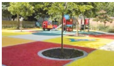
Cours d'école avec revêtement en béton drainant coloré
