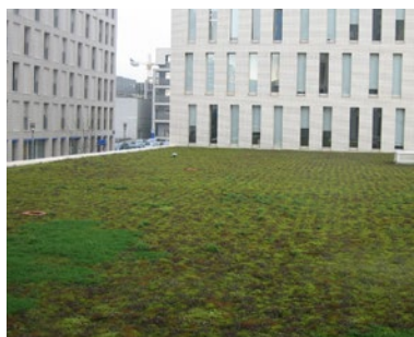
Toiture Magellan à Nantes
