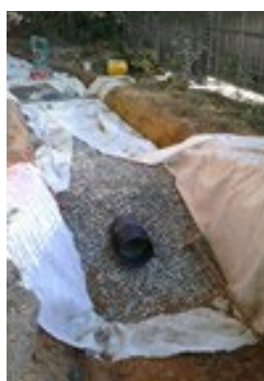
Tranchée d'infiltration sous chemin
