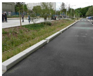
La Courneuve : noue végétalisée avec ruissellement direct
