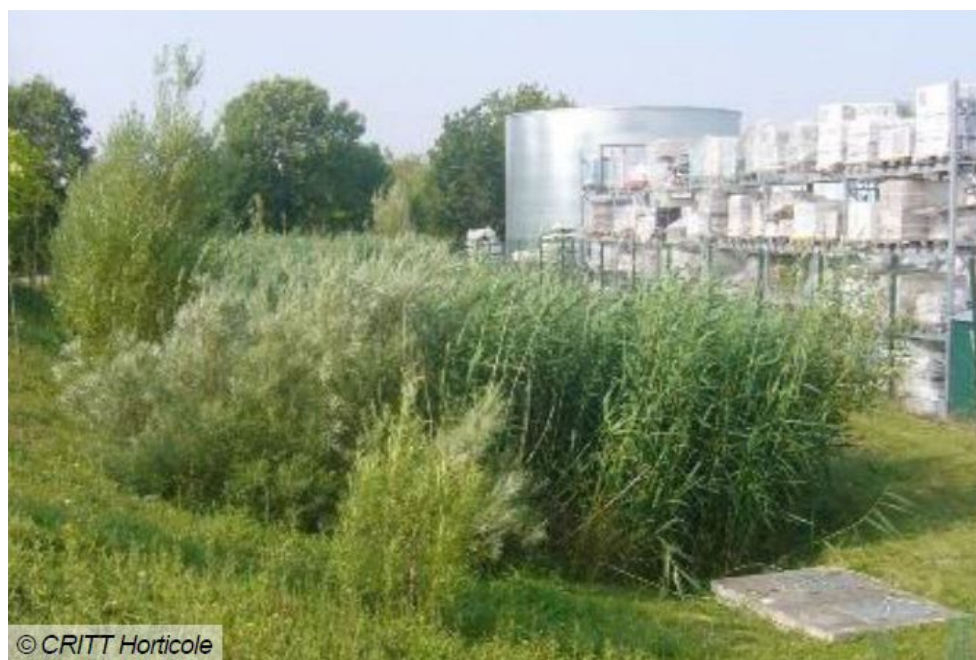
Bassin d'infiltration avec une roselière
