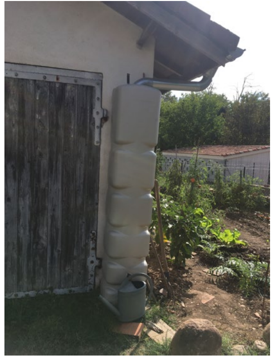
Installation de récupération de l'eau de pluie pour l'arrosage du jardin
