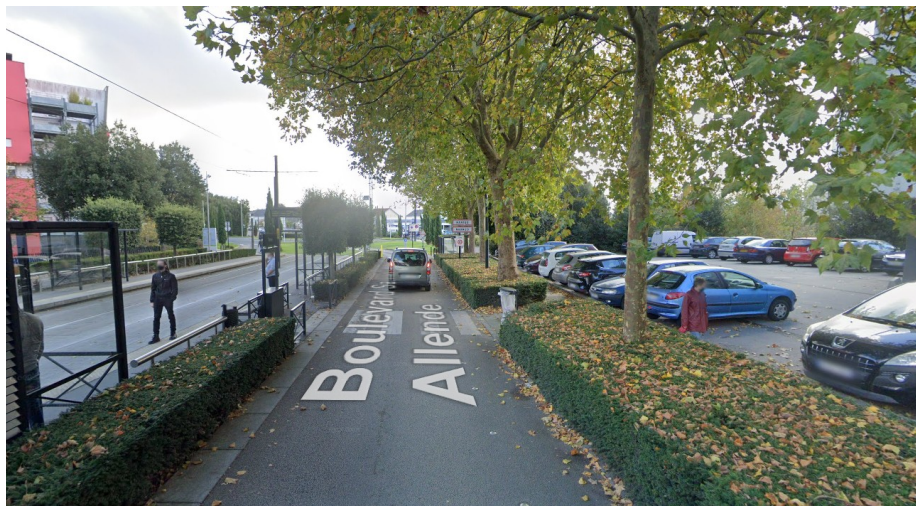
Exemple : Bd Salvador Allende à Saint-Herblain – Arbustes au droit de la chaussée, de part et d'autre
