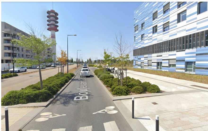
Exemple : Bd Charles Gauthier à Saint-Herblain – Arbustes au droit de la chaussée, de part et d'autre
