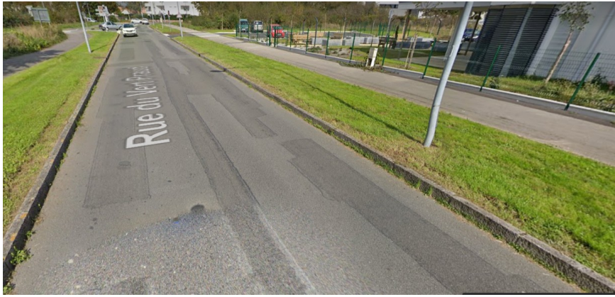
Exemple : Rue du Vert Praud à Rezé – Hauteur de vue des bordures de 18 cm
